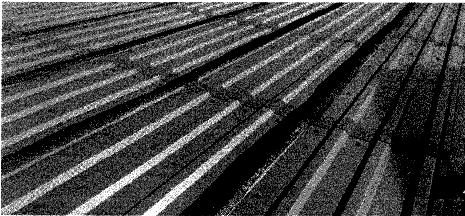
Uszczelnienia styków pokrycia dachowego
